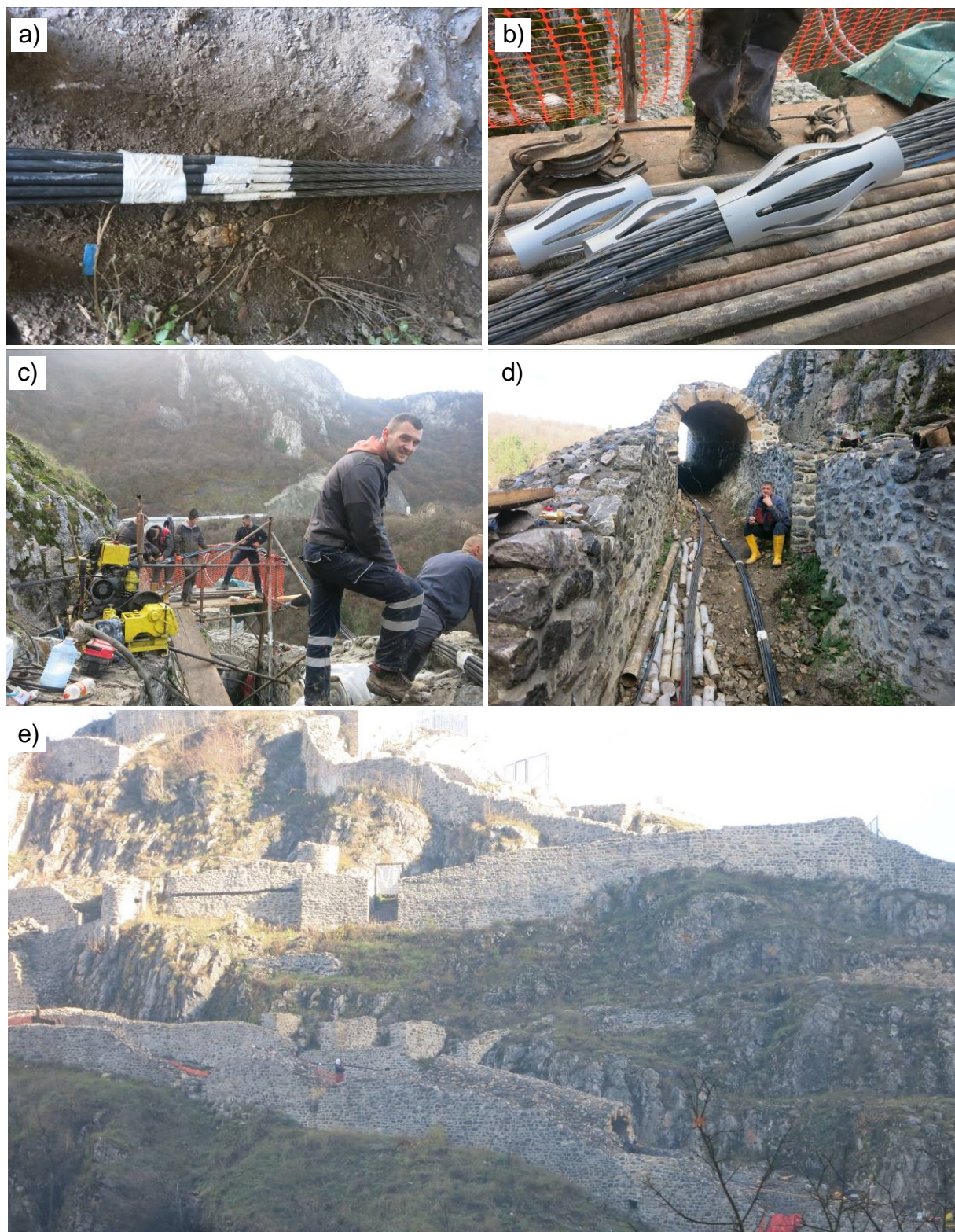
Slika 4.1 Donošenje i ugradnja geotehničkih sidara u bušotine a) prelaz sa slobodne na sidrišnu deonicu, b) izgled distancera i unutrašnjeg raspoređivača, c) proces uvlačenja sidra u bušotinu, d) izgled sidra položenog na zemlju, e) donošenje sidara na gradilište
